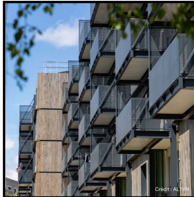
▲ Enlargement of existing balconies from 90 cm to 180 cm in depth, résidence Moulin du Bois (Atlantique Habitations)
